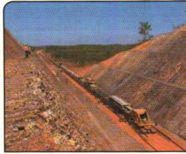
การสร้างทางรถไฟเป็นทางตัดผ่านเนินเขา (Cutting)
