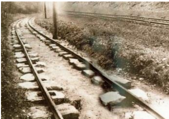
ทางรถไฟสมัยโบราณ ใช้เหล็กฉากวางบนหิน (ที่มา: http://www.jamespreller.com )
