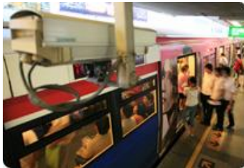
รูปที่ 5.15 กล้องวงจรปิดบริเวณขานขาลา BTS
