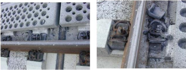
รูปที่ 6.4 การซ่อมบํารับราง (Shoulder)
