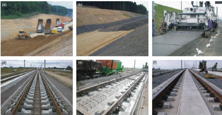
รูปที่ 6.2 การก่อสร้างทางรถไฟแบบ Slab Track
