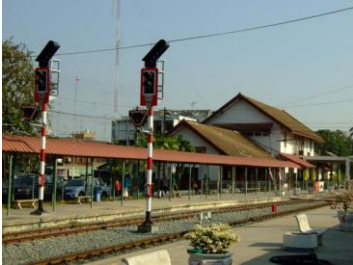
รูปที่ 5.2 อาณัติสัญญาณประจำที่ชนิดไฟสี่สองท่า
