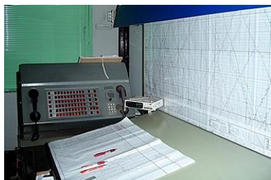
รูปที่ 5.7 ระบบโทรศัพท์ควบคุมการเดินรถ
