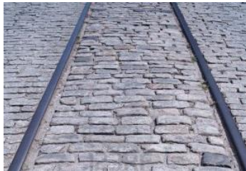
ทางรถไฟใช้คานเหล็กปูพื้นด้วยแท่งหิน (ที่มา: http://us.123rf.com )
