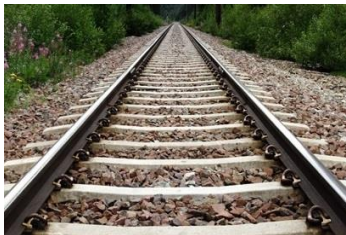
ทางรถไฟปัจจุบันวางบนหมอนคอนกรีต (ที่มา: http://faithduringreality.files.wordpress.com )
