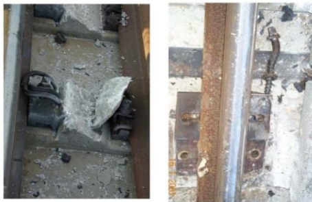
รูปที่ 6.3 การถอดเครื่องยึดเหนี่ยวราง
