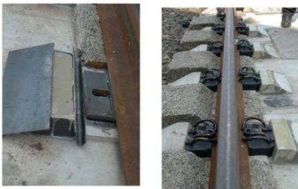
รูปที่ 6.5 การติดตั้งเครื่องยึดเหนี่ยวราง
