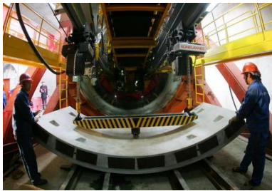
รูปที่ 2.13 การเสริม Concrete segment
